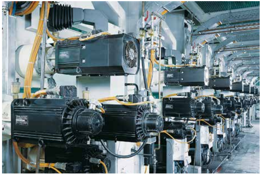
Maar liefst 20 servomotoren, drives en bijbehorende bekabeling zijn vervangen, door componenten van Bosch Rexroth. (Beeld alleen ter illustratie)
